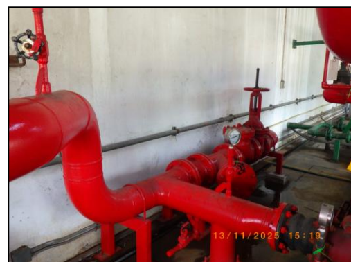
รูปที่ 3.63 เครื่องสูบน้ำดับเพลิง (Firewater Pump) บริเวณอาคาร Fire Pump
