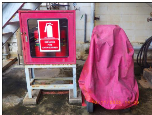
รูปที่ 3.70 ตู้ดับเพลิงชนิด CO 2 บริเวณพื้นที่กระบวนการผลิต
