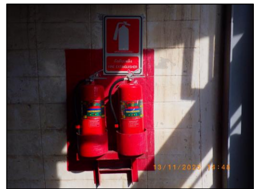
รูปที่ 3.65 ถังดับเพลิง ชนิดผงเคมีแห้งแบบมือถือ บริเวณพื้นที่กระบวนการผลิต (ต่อ)
