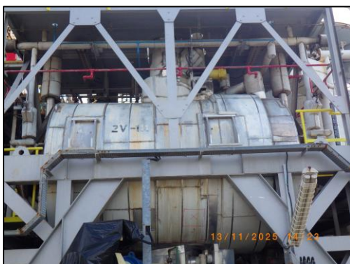
รูปที่ 3.100 Jacket ห่อหุ้มถัง R1
