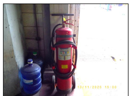
รูปที่ 3.67 ถังดับเพลิง ชนิดผงเคมีแห้งแบบล้อเข็น บริเวณอาคารซ่อมบำรุง
