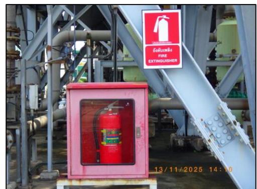
รูปที่ 3.65 ถังดับเพลิง ชนิดผงเคมีแห้งแบบมือถือ บริเวณพื้นที่กระบวนการผลิต
