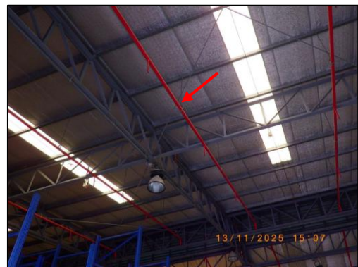
รูปที่ 3.80 Springkler Water Spray บริเวณอาคารเก็บสารเคมีส่วนกลาง
