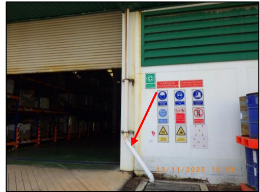
รูปที่ 3.29 รางระบายน้ำฝนจากหลังคา
