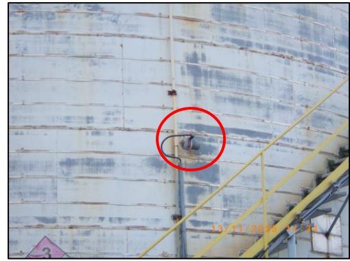
รูปที่ 3.91 Temperature Transmitter ติดกับตัวถัง SM
