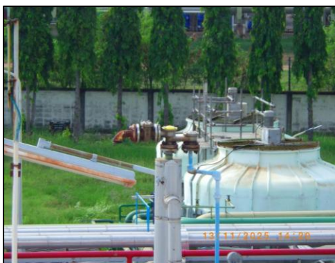
รูปที่ 3.17 เครื่องควบแน่นกลับเข้าถัง Condenser บริเวณด้านบนของถังเก็บสำรองเอทิลเบนซีน
