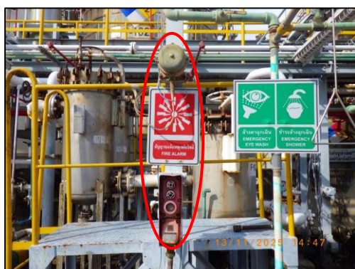
รูปที่ 3.78 สัญญาณเตือนเพลิงไหม้ (Manual Fire Alarm) บริเวณกระบวนการผลิตเม็ดพลาสติกโพลีไทรีน
