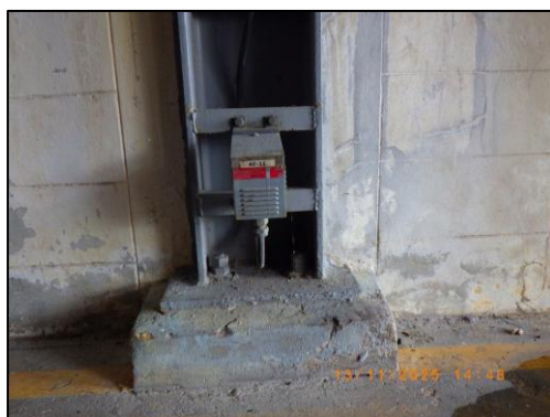
รูปที่ 3.82 อุปกรณ์ตรวจจับก๊าซ (Gas Detector) บริเวณพื้นที่กระบวนการผลิต
