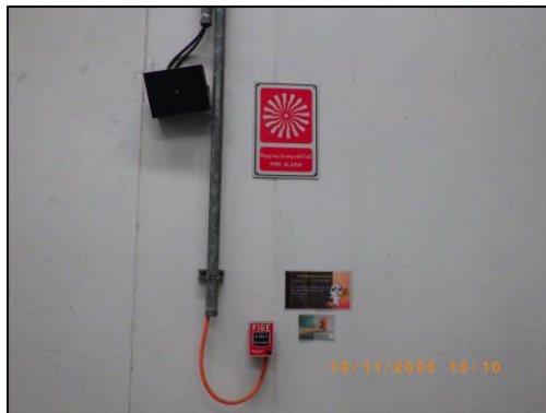
รูปที่ 3.111 Manual Pull บริเวณอาคารเก็บสารเคมี
