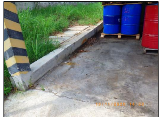
รูปที่ 3.44 คันกัน (Curb) บริเวณพื้นที่อาคารเก็บกากของเสีย
