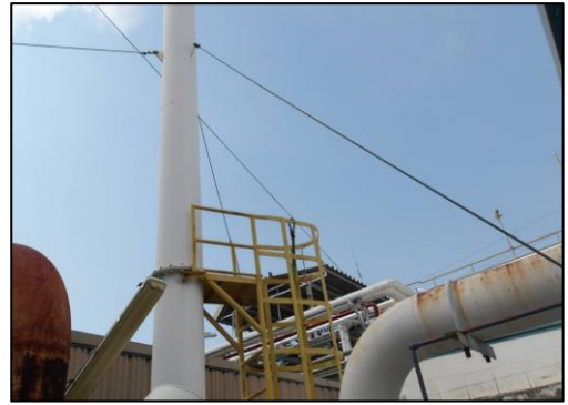
รูปที่ 3.8 ปล่อง Die-Fume Scrubber Stack of GPPS
