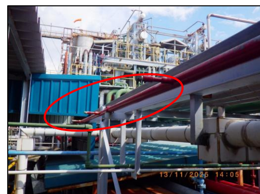
รูปที่ 3.79 Springkler Water Spray บริเวณกระบวนการผลิตเม็ดพลาสติกโพลีไทรีน
