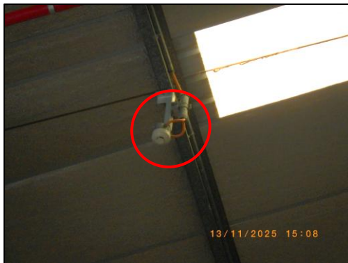
รูปที่ 3.84 Smoke Detector บริเวณอาคารเก็บสารเคมี
