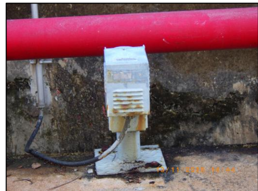
รูปที่ 3.81 อุปกรณ์ตรวจจับก๊าซ (Gas Detector) บริเวณลานถังเก็บ SM
