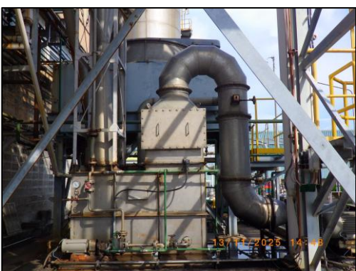
รูปที่ 3.11 ระบบ Die Fume Scrubber
