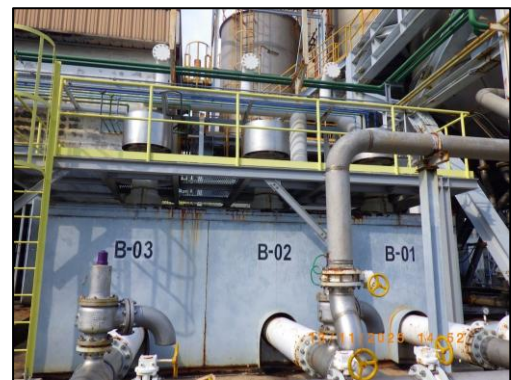
รูปที่ 3.48 Blower ติดตั้งอุปกรณ์ลดเสียงดัง
