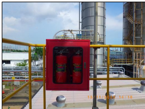
รูปที่ 3.65 ถังดับเพลิง ชนิดผงเคมีแห้งแบบมือถือ บริเวณพื้นที่กระบวนการผลิต (ต่อ)
